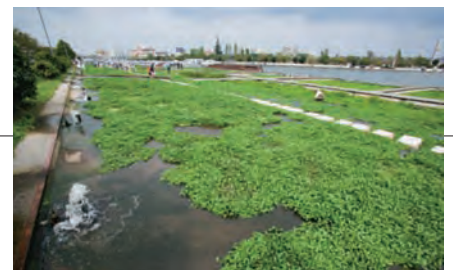
●土浦バイオパークでは、クレソンやセリなどの水生植物を利用して、植物の力で霞ヶ浦の湖水を浄化している。手前が土浦バイオパーク、奥が霞ヶ浦。くみ上げた湖水でクレソンなどが育ち、成長過程で水を浄化する。
