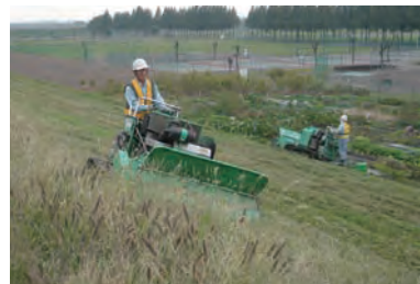
●荒川の堤防での除草。春と秋の年2回実施される。[写真提供/国土交通省荒川上流河川事務所]
