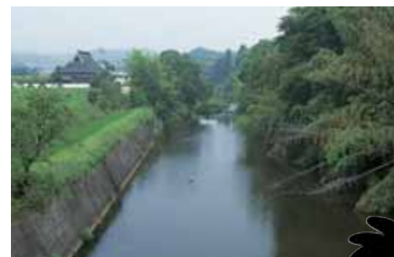
写真⑯ 水害を防ぐためにつくられたコンクリートの護岸。
