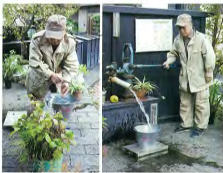
写真⑥ 墨田区に設置された雨水タンク「路地尊」。もともと防災目的で地域の一角につくられたもので、手押しポンプで地下にためた雨水をくみあげる(右)。ふだんは地区の人がこの水を植木にゆったり打ち水に使ったりしている(左)。
