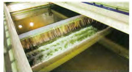
写真⑪ 砂ろ過池。ここでは、砂利(じり)と砂の2層に処理水を下から上に流すことで、これまでの処理でとりきれなかった浮遊物などをのぞき、きれいな水にする。写真中央はきれいになった水で、この水を西新宿地区の雑用水に再利用し、渋谷川などにも放流している。
