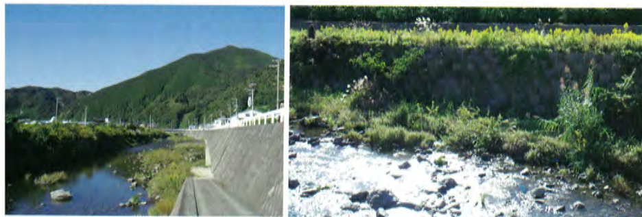
●1999年に河川改修で前田地区の左岸には穴あきブロックの護岸(左写真の左)が完成した。完成当時は右岸側の護岸(左写真の右)と同じように1本の植物も見られなかったが、それから6年たった2005年には川のなかに水草がはえ、ブロックにも植物が見られるようになった(右写真)。そしてこの年の6月、工事完成以来、はじめてホタルが飛んだ。
