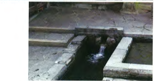
写真② 昔から島原の人々にだいに利用されてきた浜の川湧水の洗い場。洗い場は図①のように用途により4つに区切られており、一度使った水もそのまま流さず、別の区画に流してもう一度利用できるようなっている。人々は規則(下左)をまもって、この洗い場を大切にきれいに使っている。
