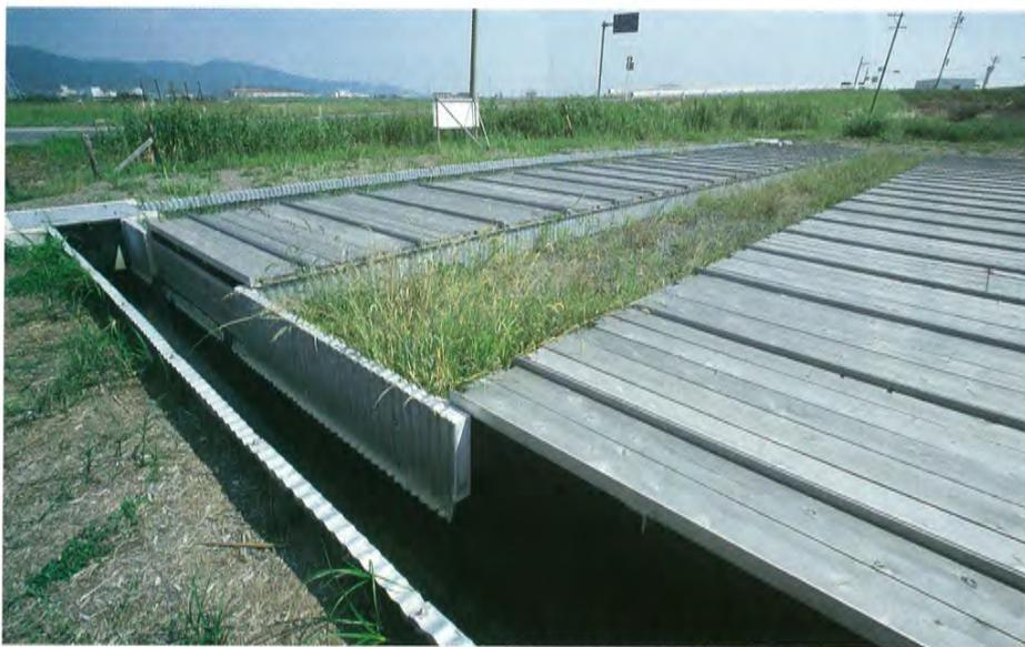
●接触酸化施設。ふたで覆われた内部に23万個の乳酸菌飲料の空き容器が入っている(右写真参照)。
