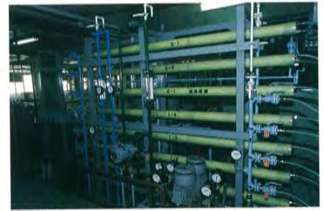
●二次処理水を高度処理するために使用されている装置のひとつ、逆浸透膜装置。
