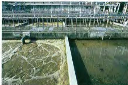
●生物反応槽。左は硝化槽、右が脱窒槽。脱窒槽のとなりには脱リン槽がある。下水の高度処理にこの3つの生物反応槽は欠かせない。
