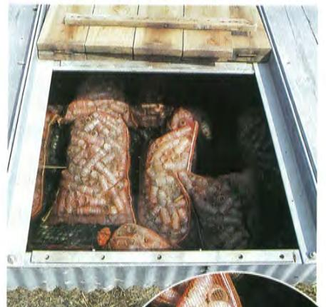
●接触酸化施設の内部。23万個の乳酸菌飲料の空き容器が接触材として利用されている。
