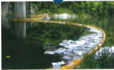
**写真⑧** 油流出事故が起きるとオイルフェンスを張って下流に油が流れるのを防ぎ、オイルマットに油を吸収させて汚染の拡大を防ぐ措置がとられる。
