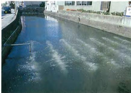
●地元の高校生の提案で設置された曝気(ばっき)式浄化施設。
