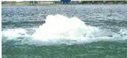
写真⑥ 植物プランクトンの1種、ホルミディウムの異常増殖でカビ臭が発生したダム湖では、水中に「間欠式空気揚水筒」を設置して空気を送って湖水をかき混ぜ、カビ臭の発生をおさえることに成功した。
