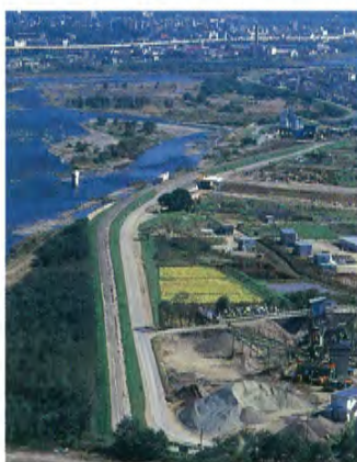
●霞堤。洪水を遊ばせるために、写真右上方で堤防が連続していない
