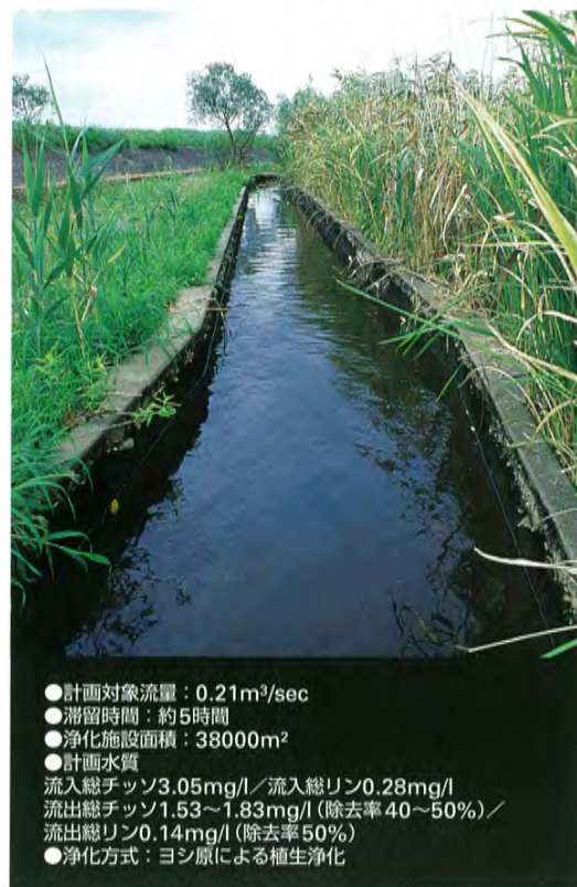
●(上)空中から見た清明川浄化施設。湖水にヨシ原が広がる [写真提供：建設省関東地方建設局霞ヶ浦工事事務所] ●(左)清明川の水は水路からヨシ原を通り、霞ヶ浦に流れこむ
