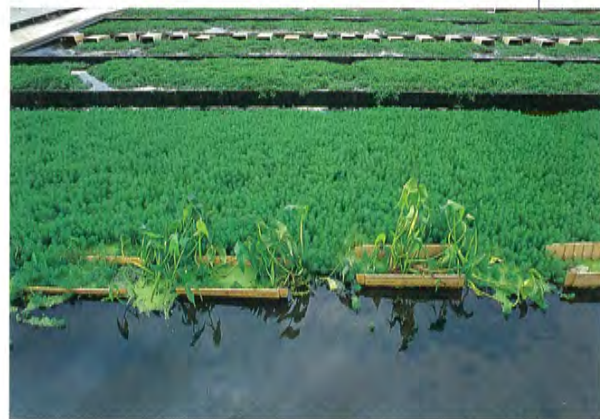
●土浦バイオパーク。クレソンなど水耕生物の浄化力を利用して霞ヶ浦の水を浄化する
