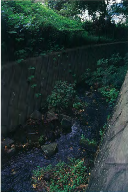
●以前に護岸工事された地区では川底から植物がはえている
