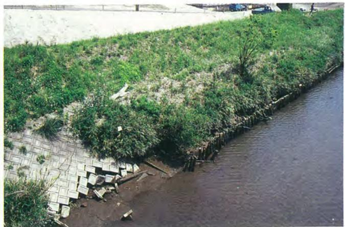
写真 6・4 河岸浸食で倒壊した護岸
