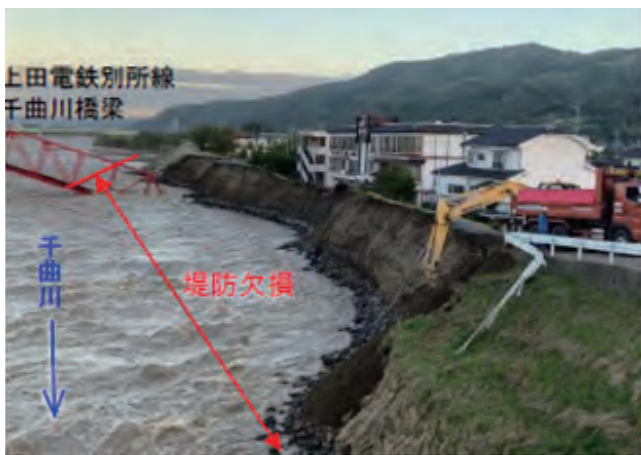
侵食・洗掘による堤防欠損(令和元年10月台風19号出水概要報告 北陸地方整備局 令和2年1月)
