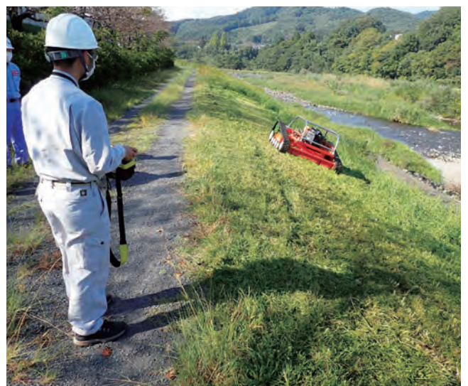
遠隔式小型除草機を用いた除草工事の効率化の試行
