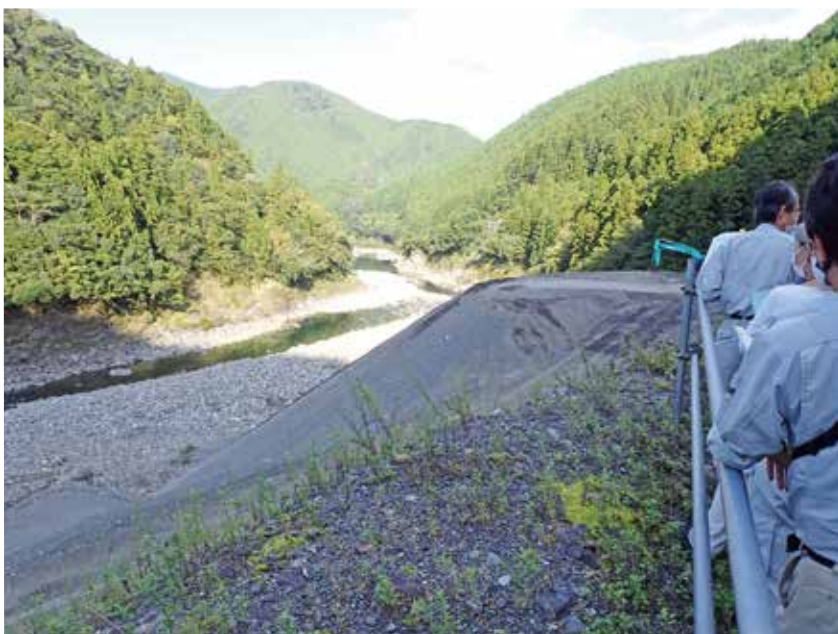
長安口ダム下流の置き土の現場
