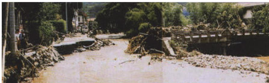
図 2-2 橋梁に流木が掛かり迂回流によって生じた侵食
