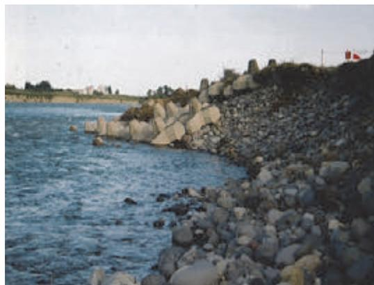
図 2-5 洪水後（左写真ヶ所）の河岸侵食地点の状況
