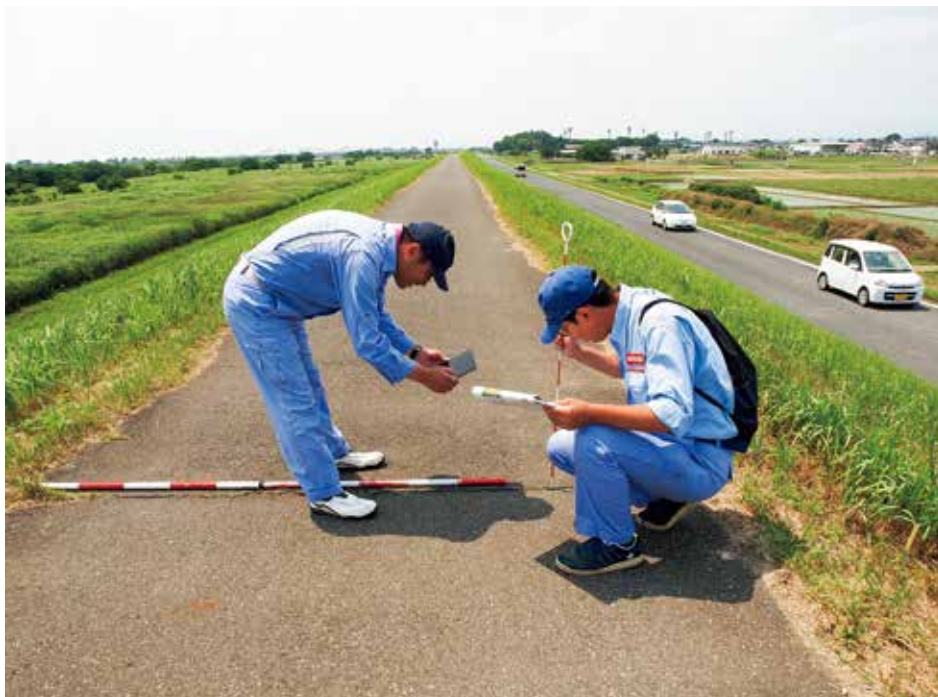
変状の写真に加えて現状（幅・開き・深さ）を記録することが重要です
