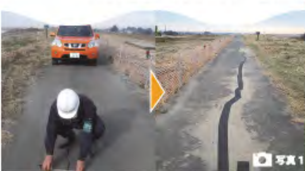
図2 「維持管理対策」の掲載事例 (堤防天端に発生した亀裂の補修)
