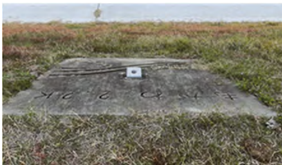
図2-2 地点Zの法面の状況 (表法肩から表法尻を撮影)
