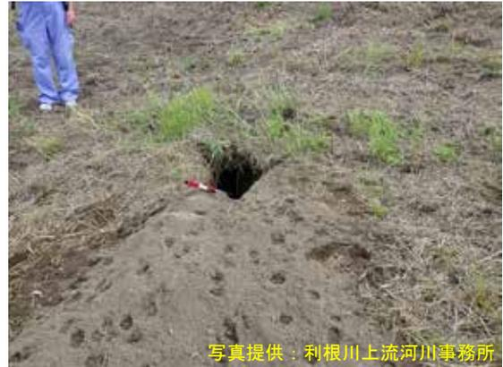
図 2-1 掘穴の例(キツネ穴)
