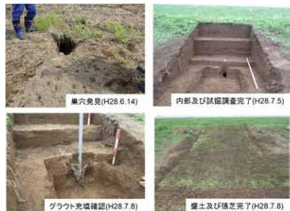
図 2-2 キツネ穴の発見～補修の事例<sup>2)</sup>
