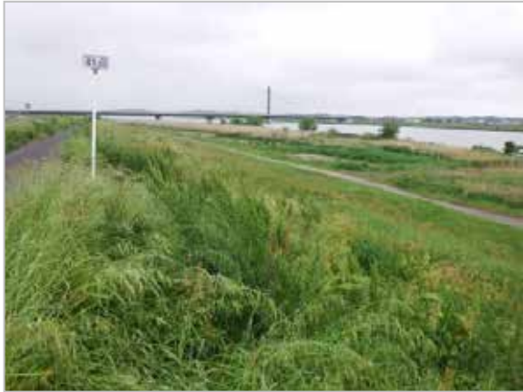
図 3・1 堤防植生（法面を覆う堤防植生）
