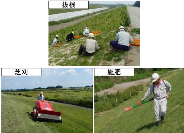
図 2-1 堤防養生工の管理手法
