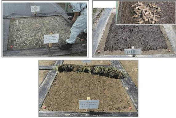
図 4・13 (左上より) 種子吹付工法, 苗吹付工法,
