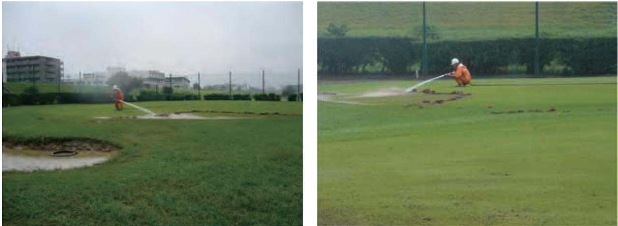
写真8.4.13 堆積した泥を散水により除去している状況
