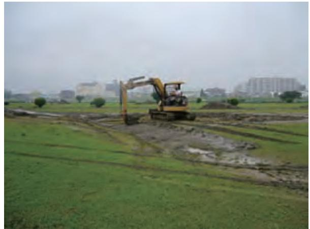
写真8.4.10 堆積した泥を重機ですきとりしている状況
