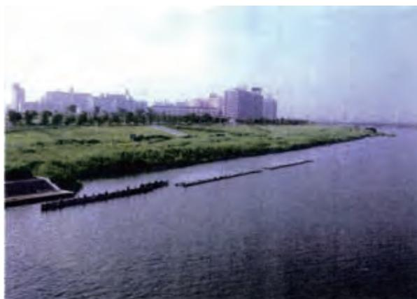
写真A.2.1 航走波対策の例(荒川, 2006)
