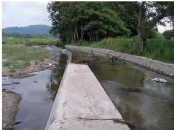
写真8.2.10 C地区の農業用水路前面の高水敷の切り下げ状況と余水吐の延長
