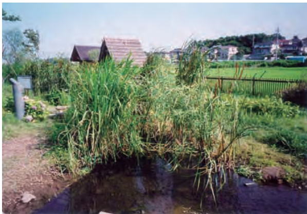
③植生浄化水路流入部
