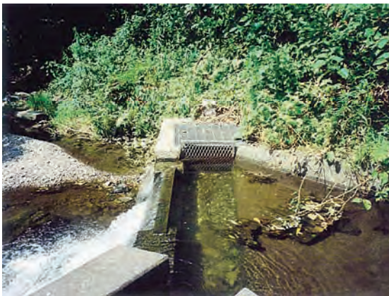
①取水部は堰が設けられ塩ビパイプで導水
