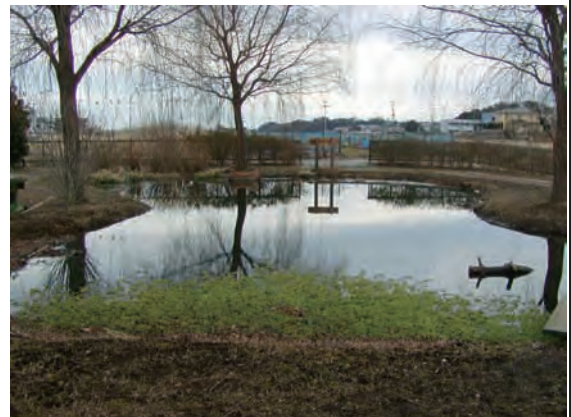
④植生浄化池
