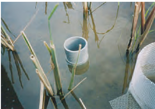
③各槽からの越流部
