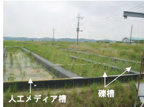
植栽当初の人工メディア槽と礫槽
