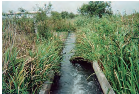
②導水路 (右が植生槽)
