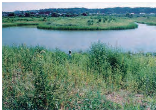
③第二植生浄化池 (第四浄化)
