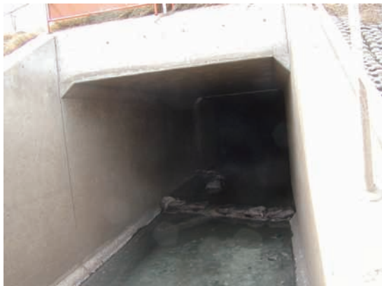
①排水路取水部
