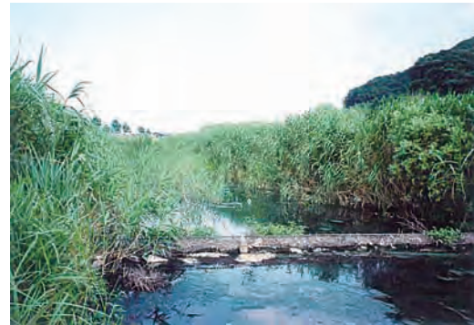
②植生槽流入地点
