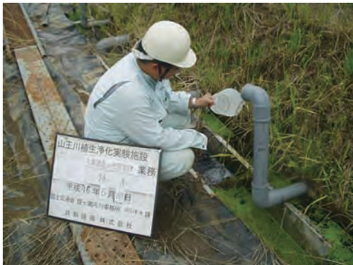
③浸透流れ槽からの流出部
