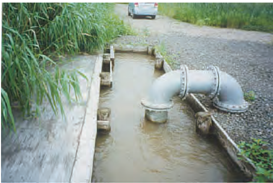
①ポンプ取水の施設側
