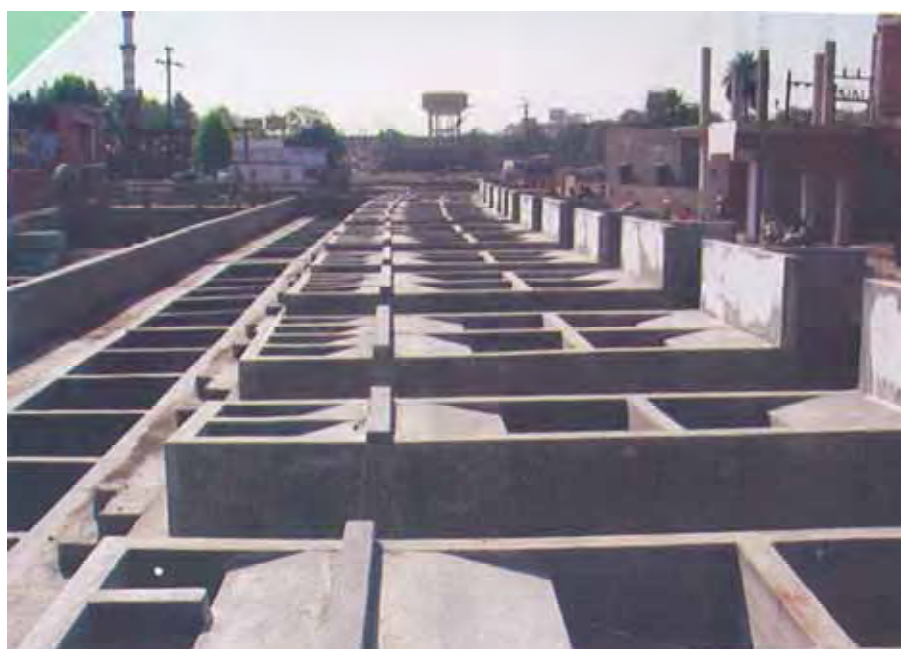
(写真 - 5 : 洗濯民による洗濯場所の移設のために建設された洗濯施設、多数の洗濯槽がある。)
