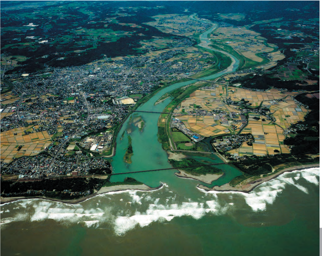
官崎河川国道事務所 撮影 (2006年)
