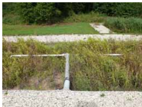
写真 4-7 第1ステージの汚水散水管
