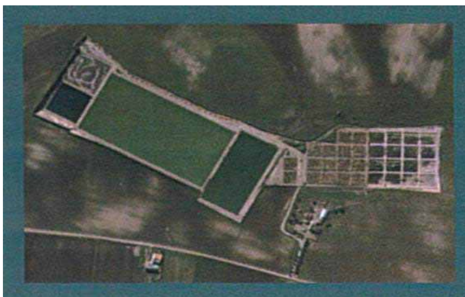
図 3-8 Sado 下水処理場の施設全景
