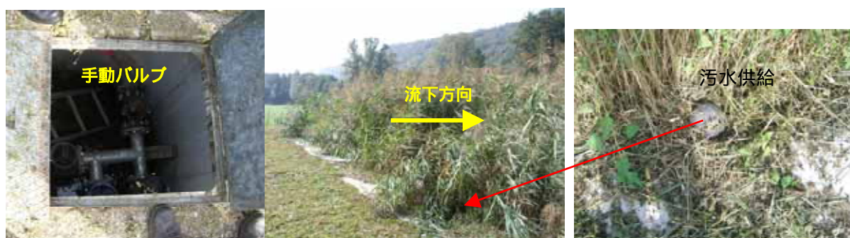
写真 4-3 第1ステージへの汚水供給
