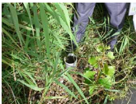
写真 4-10 第2ステージへの汚水供給 (第1ステージとの高低差による自動供給)
