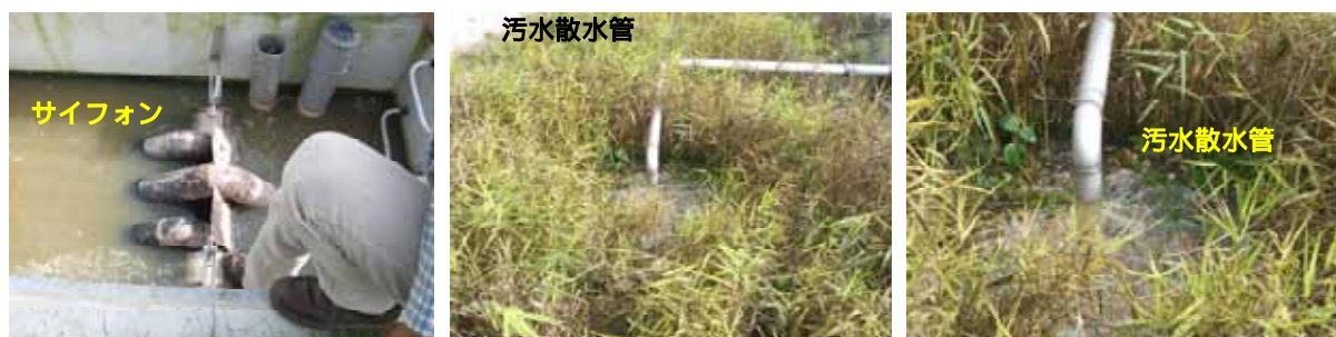
写真 4-8 第1ステージへの汚水供給
