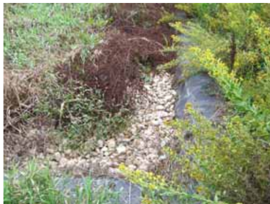
写真 3-6 集水管が埋設された周辺部レキ層
