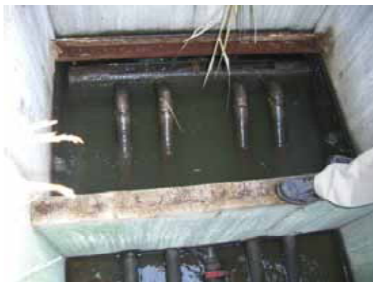
写真 4-5 第2ステージへの汚水供給システム (サイフォン・一定量汚水が溜まると第2ステージへ供給)
