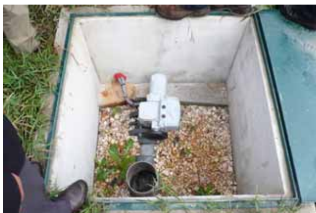
写真 3-8 水位調節用電動バルブ
