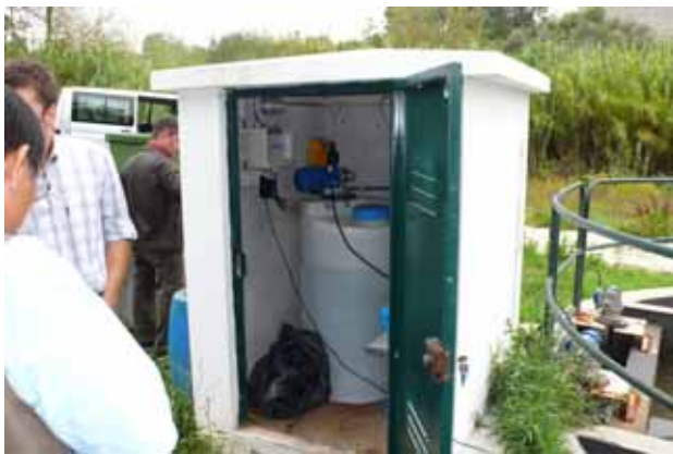
写真 3-3 凝集剤注入装置
