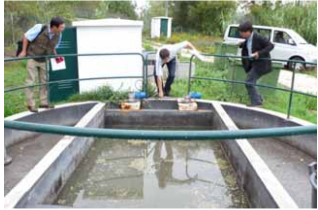
写真 3-2 インホフ・タンク
