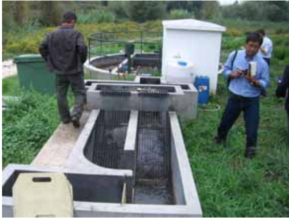
写真 3-1 インホフ・タンク前段のスクリーン
