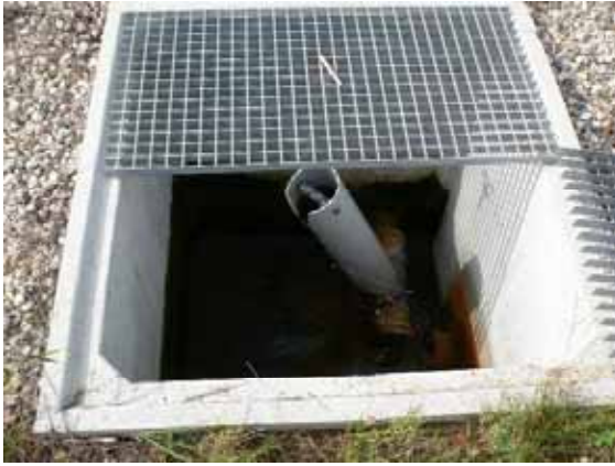
写真 4-11 第 2 ステージの水位調整管 (管を上下させることにより水位調整)
