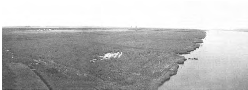
写真 2.4.3 利根川 27.2 km 地点左岸の様子 (1991 年 8 月 11 日)
