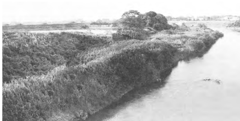
写真 2.4.2 鬼怒川 31.7 km 地点の右岸の様子（1993 年 9 月 28 日）
