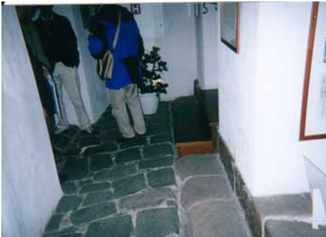
写真 1 2 旧橋の一部を利用したレストランの入口
