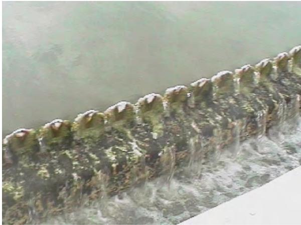
写真 5.19 最終沈殿池排出（スケール付着）状況
