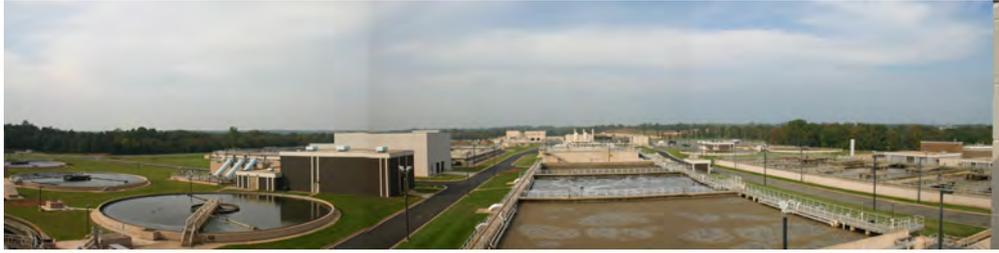
写真 5.17 反応タンク（中央四角の池）と最終沈殿池（左）
