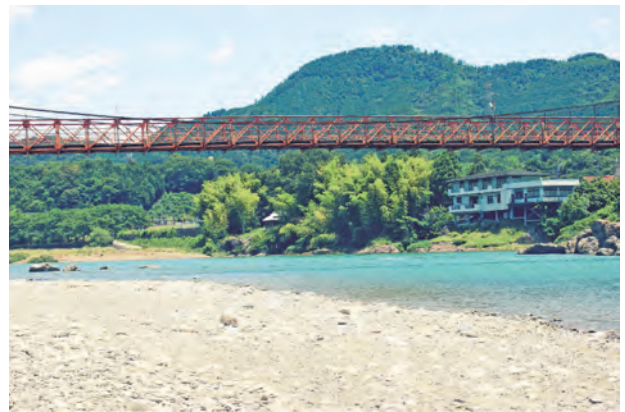
図3・1 岐阜県美濃市・長良川「美濃橋付近」
