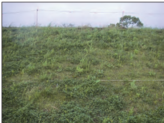
写真4・11 調査地の状況（平成26年6月）
