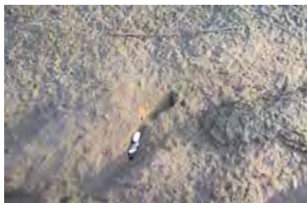
図 4.8 小礫で生じた小さいポットホール
