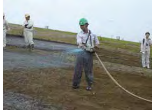
写真 4.4 種子吹付工法による施工
