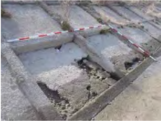
図3・6 法枠工の破損例（大和川左岸3.4km付近）
