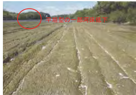
図 4.4 縦溝筋の状況 (3km 滝下橋下流)
