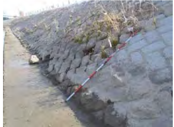
図 3・5 石積護岸の不陸・欠損例（大和川左岸 3.4km 付近）
