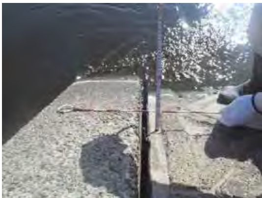
図3・7 護岸端部の小口止の沈下・傾斜の例（大和川右岸8.4km付近）
