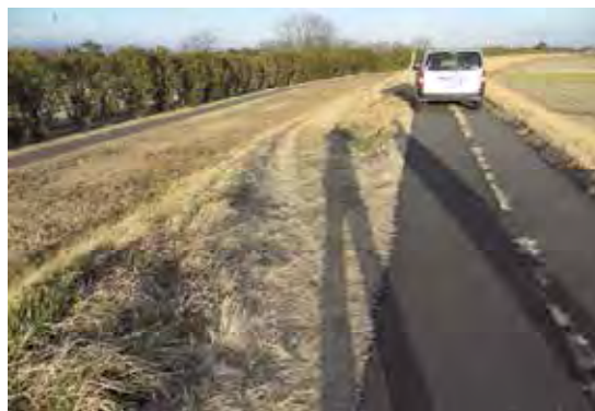
写真 2・1 堤防天端の状況 (右岸 3.0k 付近)
