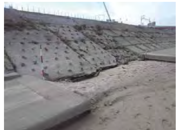
図 3・6 コンクリート護岸の破損例（大和川左岸 4.0km 付近）
