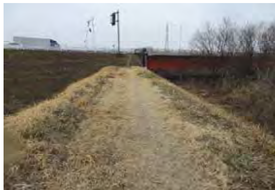
写真 2・2 関越自動車道との立体交差
