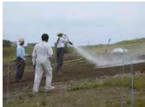
写真 4.6 客土吹付工法による施工
