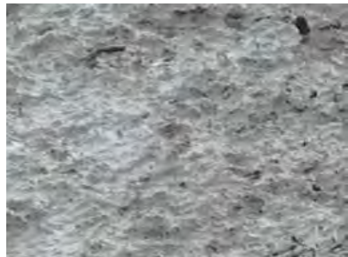
写真 4.7 客土吹付 (2cm 厚) 施工
