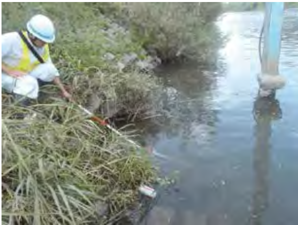
図 3・4 接続ブロック張り護岸の沈下・破損例（大和川左岸 29.2km 付近）
