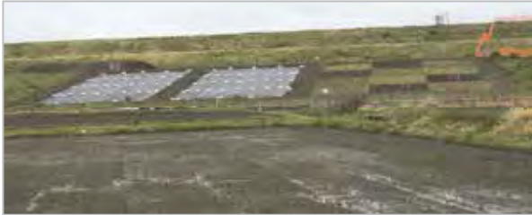
写真 4.1 現地実証実験地 施工前状況
