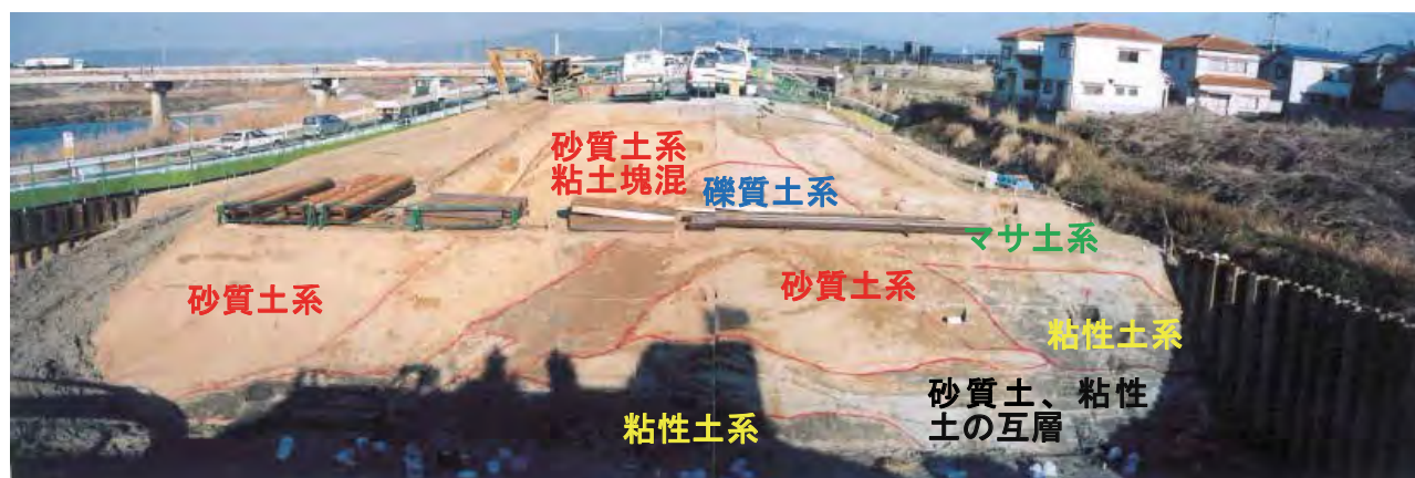
図 2・3 築造年代による堤防土質の違い（大和川左岸 32.4km, 平成 11 年度調査）
