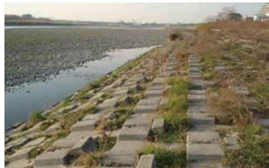
写真 4・2 連節ブロック護岸
