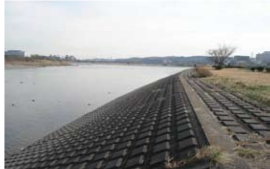
写真 4・1 コンクリートブロック張り護岸
