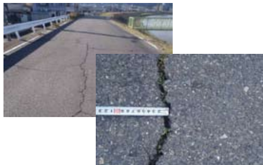
写真 3・1 堤防天端の亀裂事例
