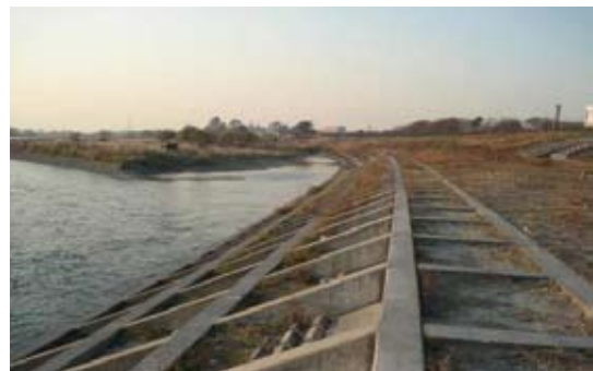
写真 4・3 法枠工
