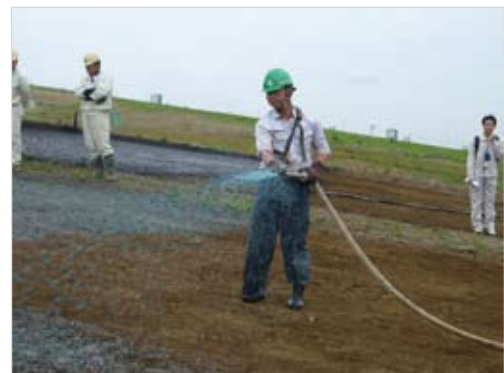
写真 4.5 種子吹付工法による施工
