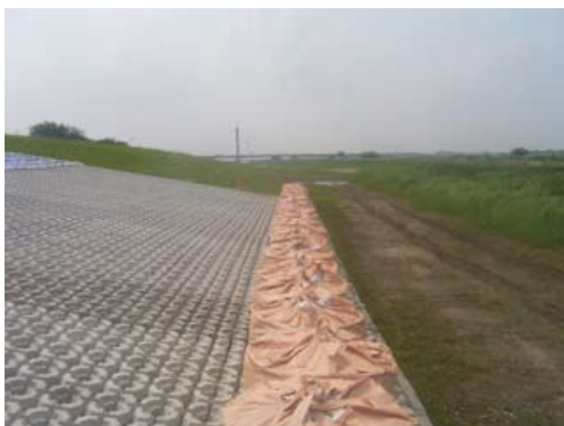
写真 4・4 応急復旧箇所における高水護岸
