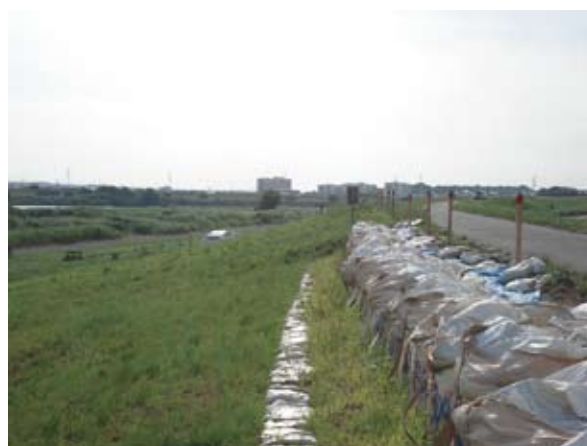
写真4・2 植生工を実施した法面
