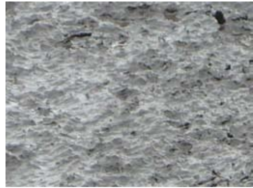
写真 4.4 客土吹付（2cm厚）施工
