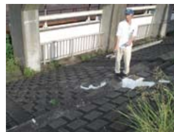
写真 3・2 横断工作物周辺の護岸の沈下事例
