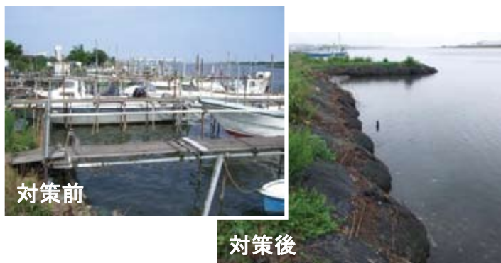
写真 3・8 護岸整備による係留再発防止の例
