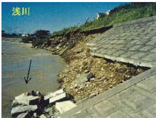
写真 4・5 局所洗掘による護岸基礎の吹出しによる被災事例
