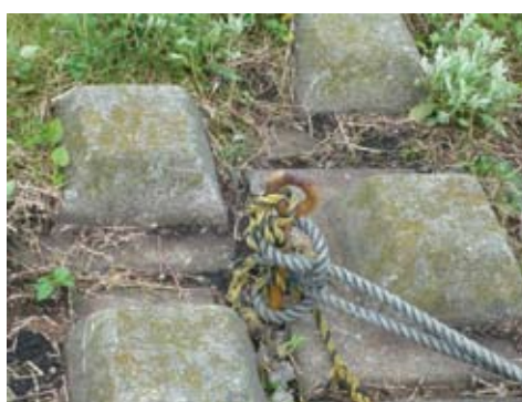
写真2・2 護岸部に打ち込まれた係留杭
