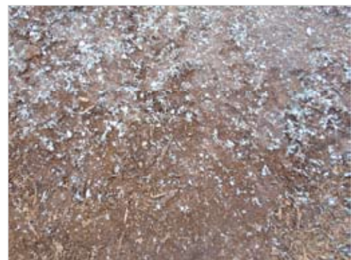
写真 4.6 種子吹付施工
