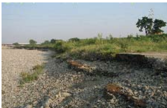
写真4・9 カゴ護岸の被災事例
