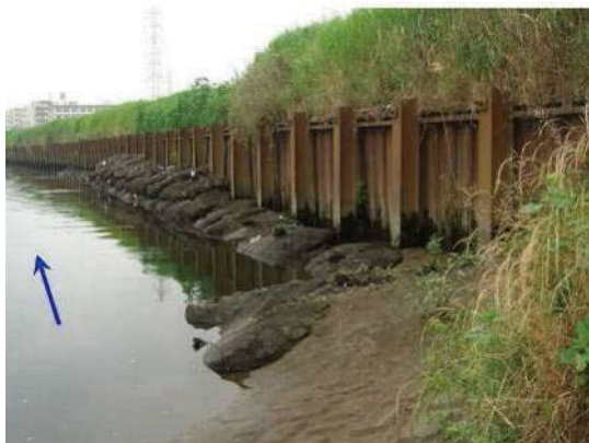
写真 4・6 矢板護岸の傾倒事例
