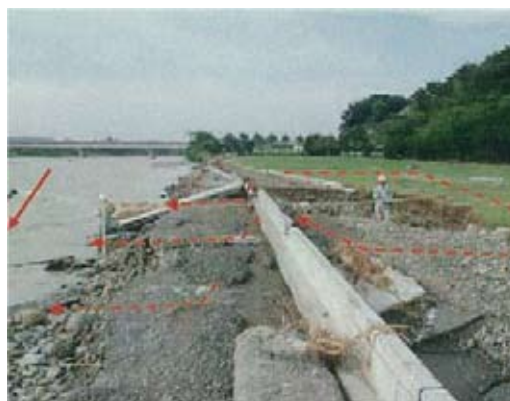
写真4・10 背面土砂の侵食・洗掘事例
