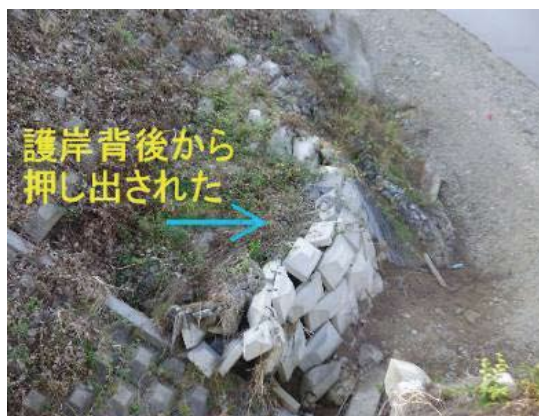
写真4・8 連節ブロックのはらみだし事例
