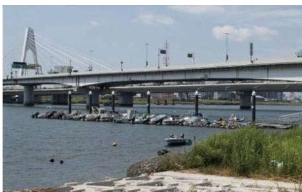
写真 3・4 暫定係留施設の例
