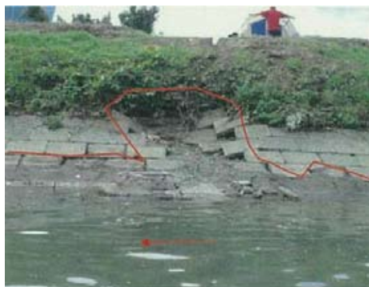
写真 4・7 コンクリートブロックの沈下事例
