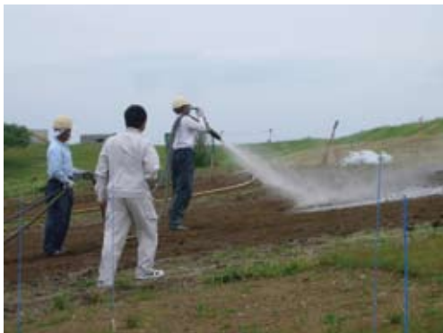
写真 4.3 客土吹付工法による施工
