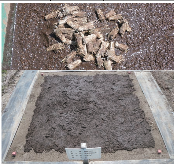
写真 4・5 苗吹付工施工時
