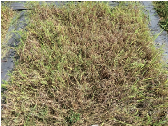
写真 4・22 H22年7月施工植生マット工 1年後(10cm程度に除草後[除草前草丈110cm])
