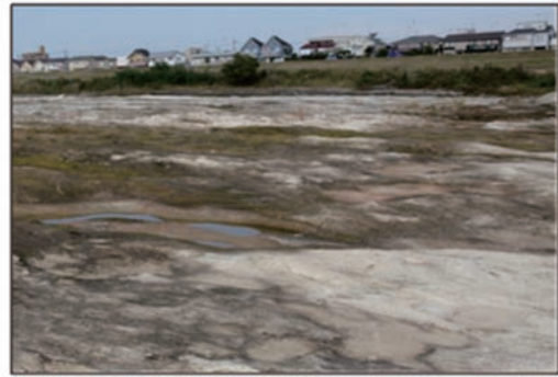
④植生の消失・減少 (土丹層の全面的な露出)
