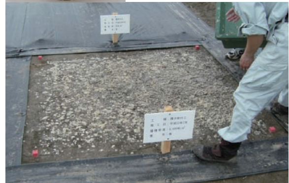
写真 4・4 種子吹付工施工時
