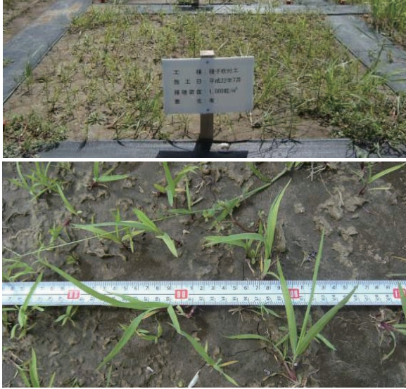
写真 4・9 H22年7月施工種子吹付工(1,000粒/m 2 )
