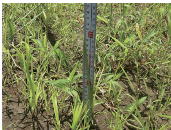
写真 4・7 H22年7月施工種子吹付工(5,000粒/m 2 ) 7週間後(草丈6～19cm)
