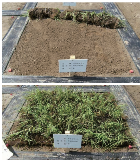
写真 4・6 植生マット工施工時
