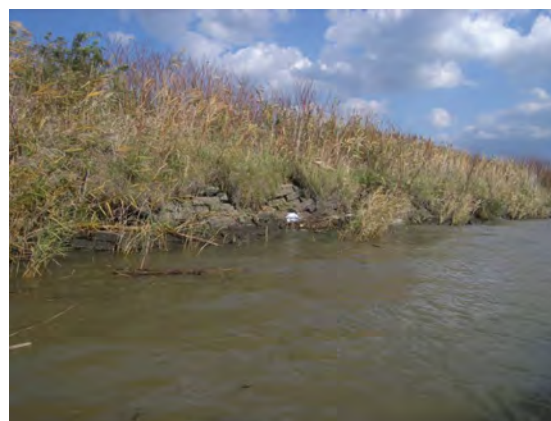
写真 5・1 低水護岸の変状の例 (H20 調査)
