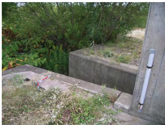
写真 5・3 取付護岸の変形の例 (H20 調査)
