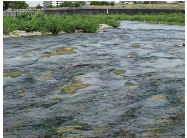
写真 2・13 二ヶ領宿河原堰(22.4km)下流の河床状況
