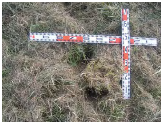
写真 5・2 のり面の亀裂の例 (H20 調査)
