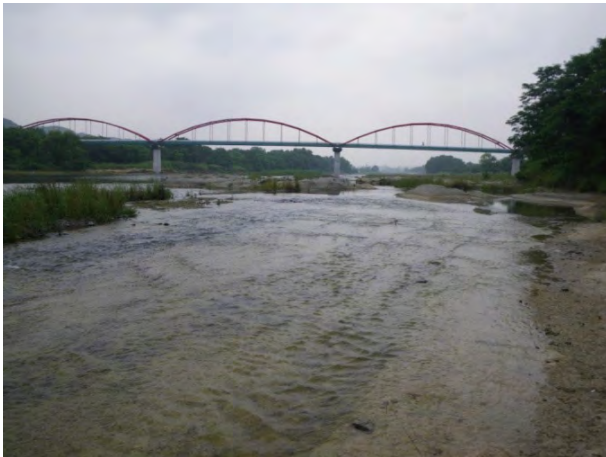
写真 3・1 水管橋（47.1km）下流の粘性土・軟岩の露出により河床が単調化した状況
