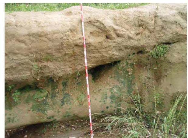
写真2・5 オーバーハングした河岸（水管橋付近）
