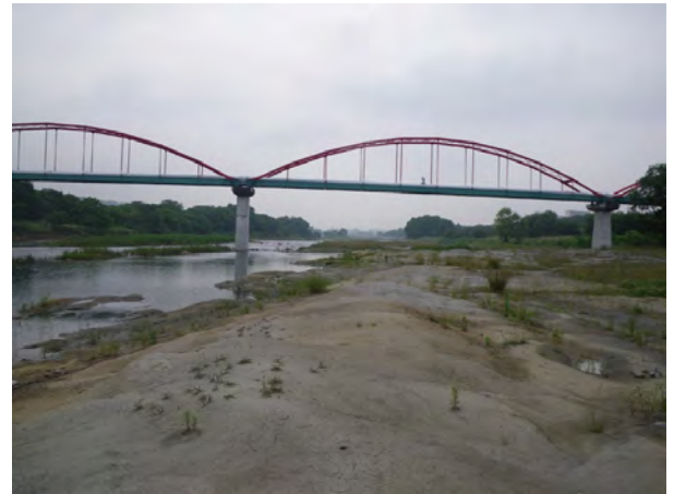
写真2・3 水道橋（47.2km）付近の左岸河床状況
