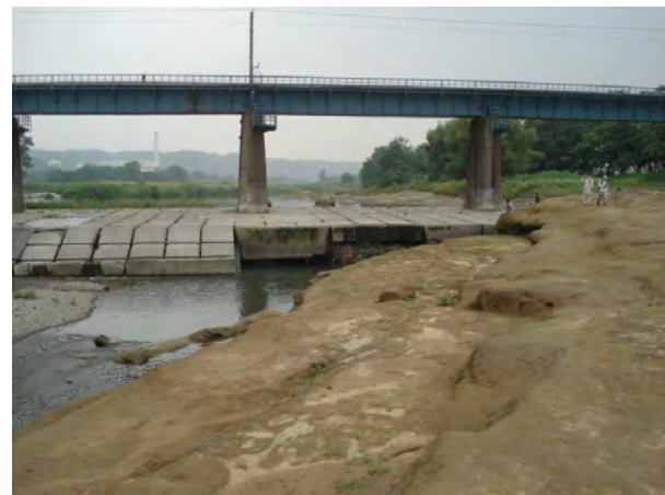
写真 2・9 八高線橋梁（44.9km）下流側
