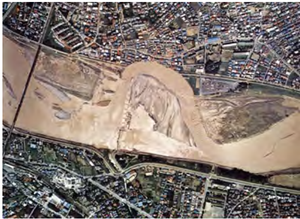
写真 2・11 S49 出水における決壊直後の状況
