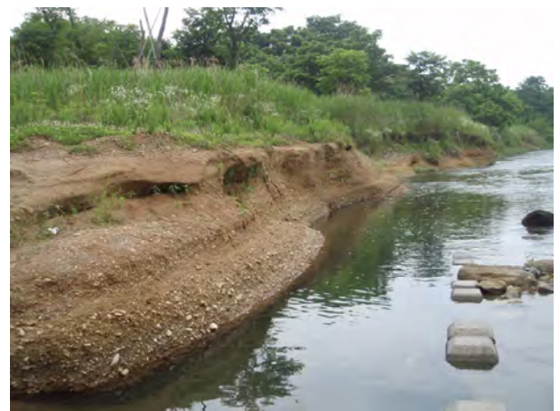
写真2・4 水道橋上流右岸側河岸(47.2km)
