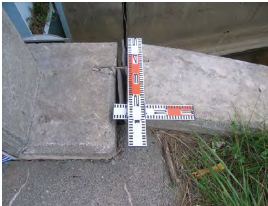
写真 5.5 部材接合部の開口の例 (H20 調査)
