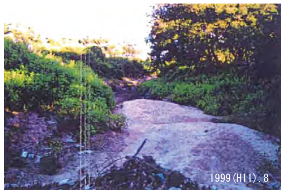
図3・21 楠葉人工タマリの造成直後の水域形成状況と同年出水後の土砂堆積状況
