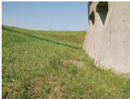
写真 5・4 施設周辺の堤防との段差の例 (H20 調査)
