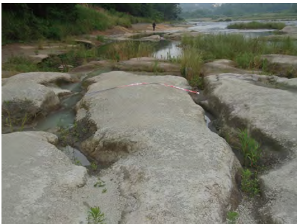
写真 2・7 河床の風化・侵食状況(47.2km)
