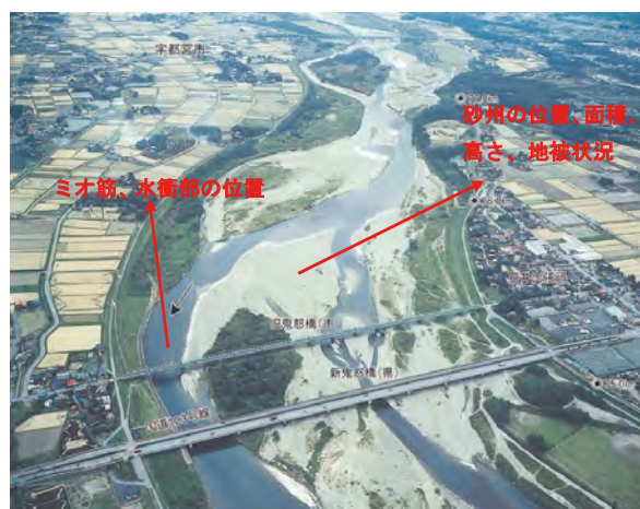
写真4・3 砂州の監視のポイント
