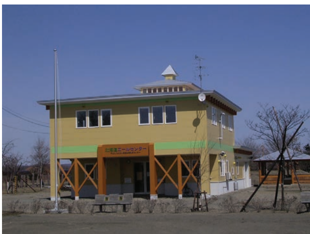
写真4・1 北海道エールセンター
