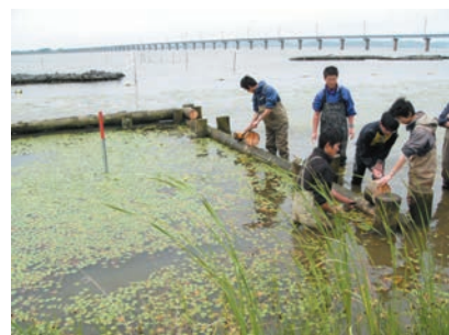
杭柵工の一部撤去(大船津 平成 17 年 7 月)
