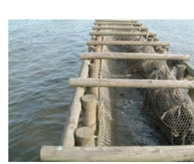
図4・2 粗朶消波工の損傷
