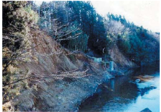
写真3・4 新期泥流（火山碎屑物）の河岸（黒川9.0km付近）
