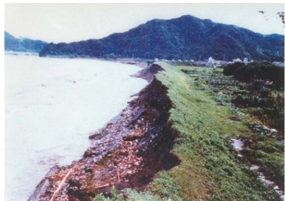
図1・1 堤防侵食の事例
