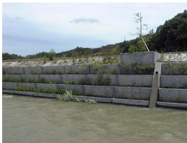
図3・2 施工直後の護岸状態
