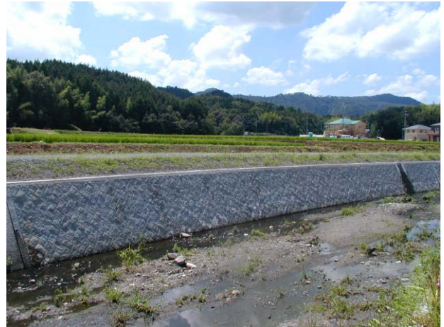
図3・4 間知ブロック区間の状況
