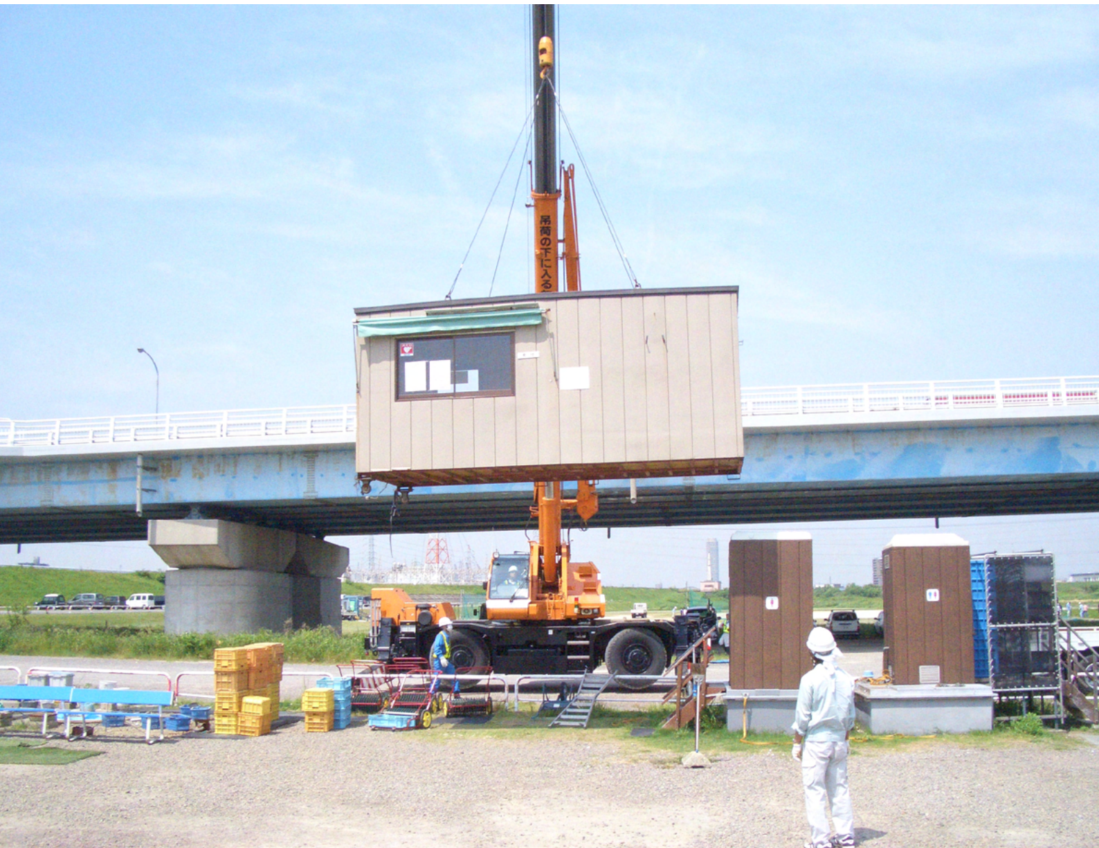
ゴルフ練習場ユニットハウス撤去状況
