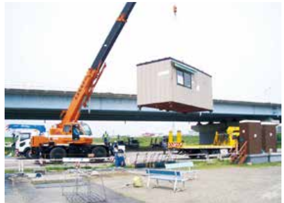
ゴルフ練習場ユニットハウス撤去状況
