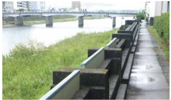
五ヶ瀬川に現存する伝統的水防工法『畳堤』（洪水時に家庭の畳を持ち寄り、畳堤のすき間に差し込んで被害をくい止めます）
