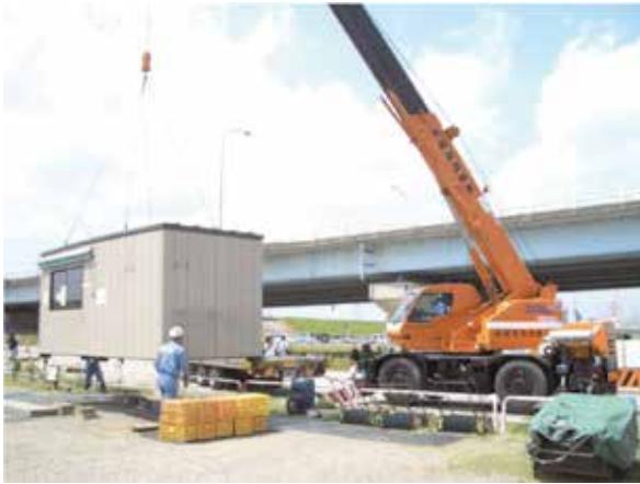
クレーンによりハウスの撤去をおこないました
