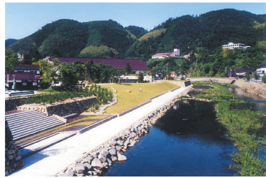
整備後の現場
