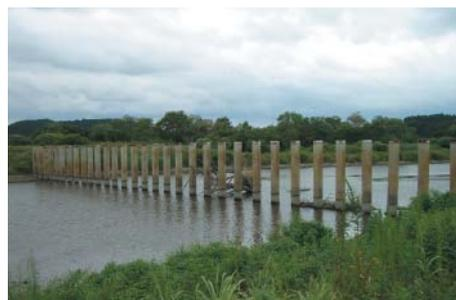
低水路の洲を開削した迂回水路に設けた流木補足工(北上川支川砂鉄川)
