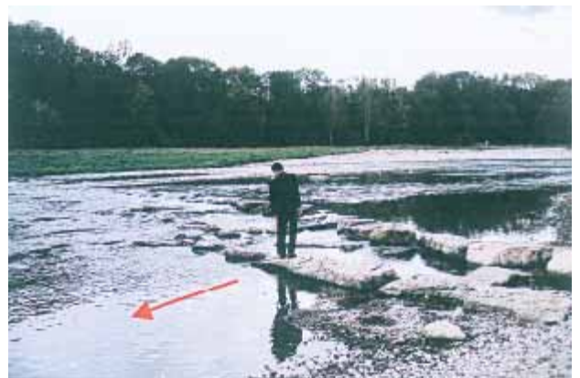
再自然化を目的に改修された落差工（Isar川、ミュンヘン）
