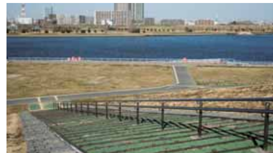
●子どもやお年寄りも安全に水際に行けるように、こう配がゆるやかで広い階段。手すりも上下にふたつついて、安全性に配慮している。岩瀬地区にて。
