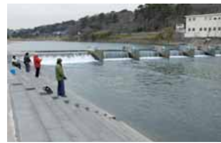
写真④ きれいになった多摩川 下水道整備や家庭できかない排水を流さないようにする努力が実って、一時汚れが目立った多摩川もきれいになった。
