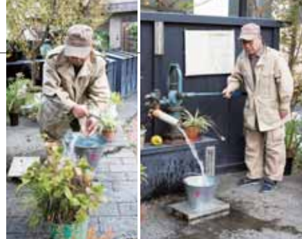
写真⑥ 墨田区に設置された雨水タンク「路地尊」。もともと防災目的で地域の一角につくられたもので、手押しポンプで地下にためた雨水をくみあげる(右)。ふだんは地区の人がこの水を植木にやったり打ち水に使ったりしている(左)。
