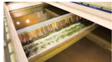
写真⑪ 砂ろ過池。ここでは、砂利(じゃり)と砂の2層に処理水を下から上に流すことで、これまでの処理でとれきれなかった浮遊物などをのぞき、きれいな水にする。写真中央はきれいになった水で、この水を西新宿地区の雑用水に再利用し、渋谷川などにも放流している。
