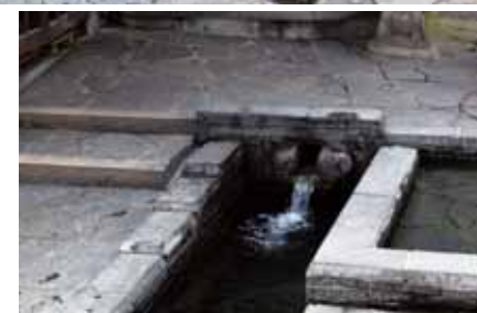
写真② 昔から島原の人々にだいに利用されてきた浜の川湧水の洗い場。洗い場は図①のように用途により4つに区切られており、一度使った水もそのまま流さず、別の区画に流してもう一度利用できるようにしている。人々は規則(左)をまもって、この洗い場を大切にきれいに使っている。
