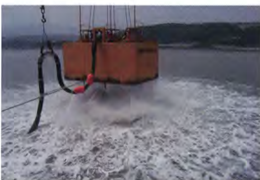
●カキ殻粉砕には、高圧ジェット噴射を利用した水のカキ殻を粉砕する工法が用いられた。[写真提供/山口県環境生活部]
