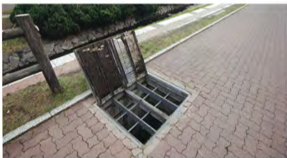
●安春川の両岸に設置されている流雪溝。ふたをあけて雪を投入する(上)。冬季、道路から、除雪して押しつけた雪でできる雪山が姿を消した(下)。[下の写真提供/札幌市建設局下水道河川部]
