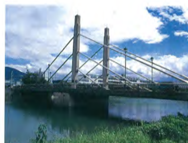
豊後橋（音の橋）
