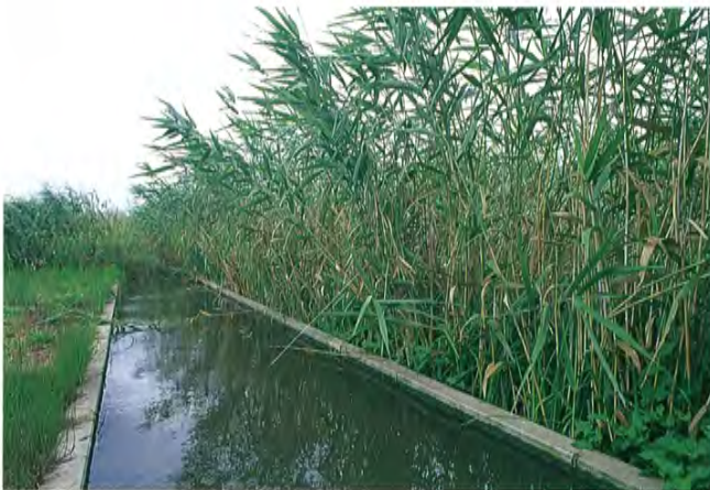
ヨシ原を利用した清明川浄化施設
