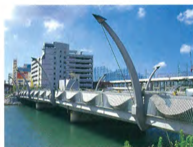
室町大橋(火の橋)
