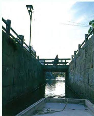
江戸時代につくられた水門、城堀水門
