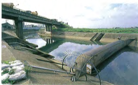
平瀬川浄化施設のラバー堰
