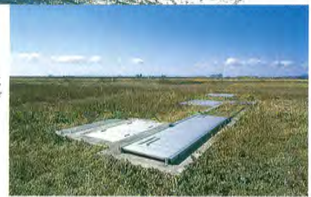
河川敷の下に 礫間接触酸化施設が 設置されている
