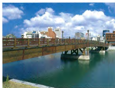
常盤橋(木の橋)
