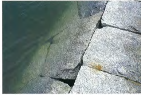
石組みの隙間に カニが棲みついた 多自然型護岸
