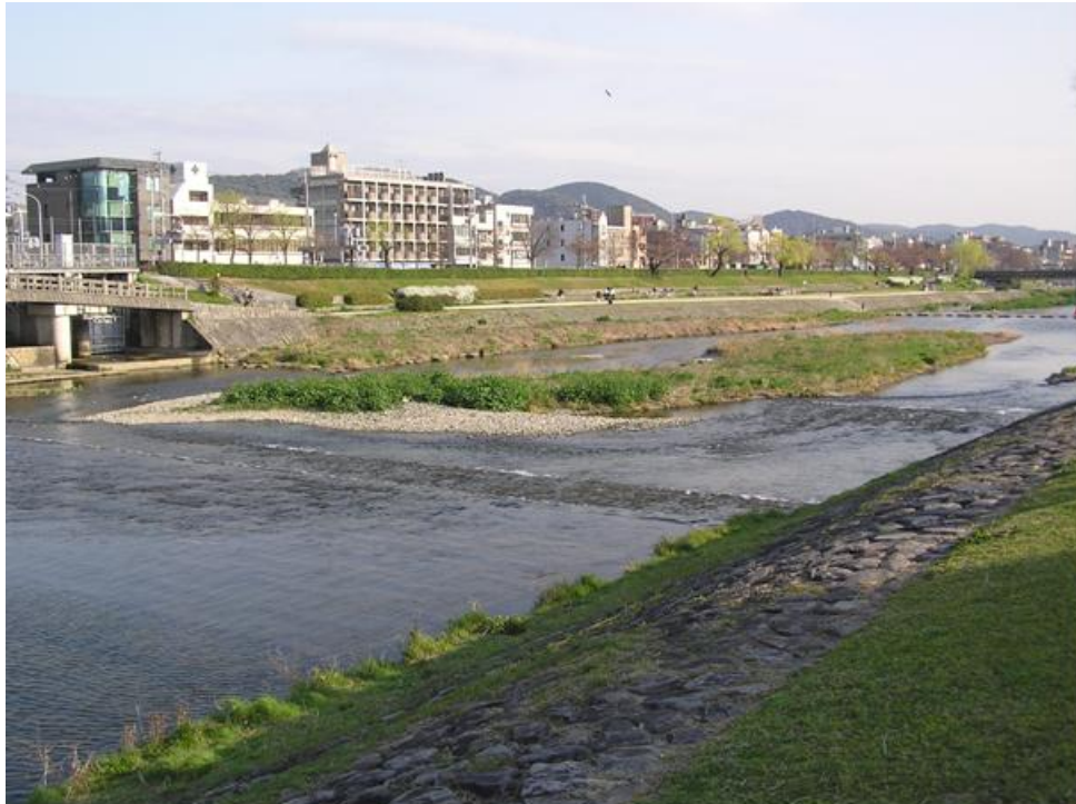
図-10 砂州（丸太町橋下流）の上流部での砂礫の新たな堆積状況（2009年4月）
