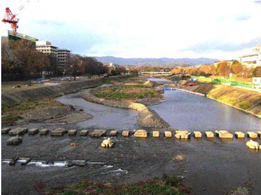
図-6 白川放水路の放水口関連工事時の状況 (2007年12月)
