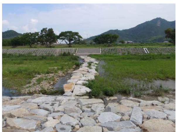
写真 2・4 飛び石工(2008. 9. 6 左岸から撮影)
