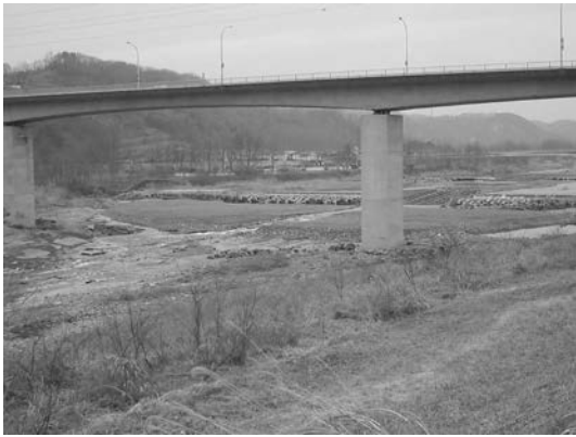
浚渫土砂採取地の遠景
