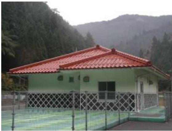
写真 付-2 奥山形農業集落排水処理施設
