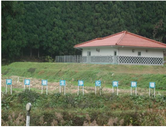
写真 付-1 芦津植生浄化実験場
