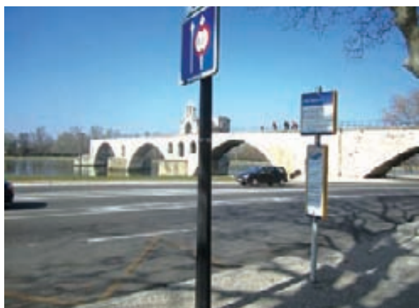
サン・ベネゼ橋の全景
