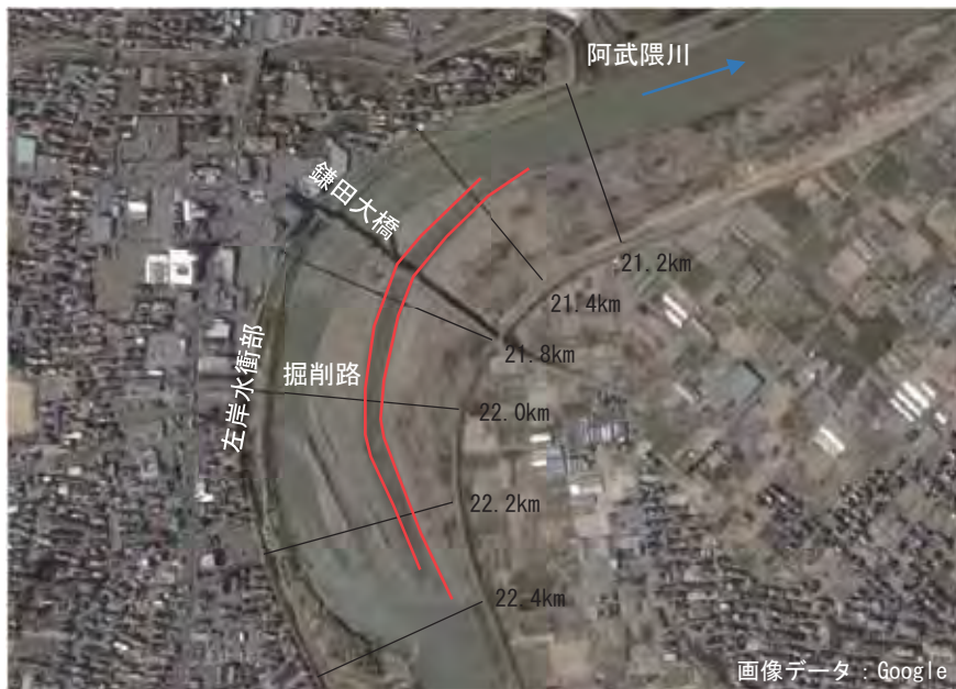
図 5.4.3 掘削路の施工状況
