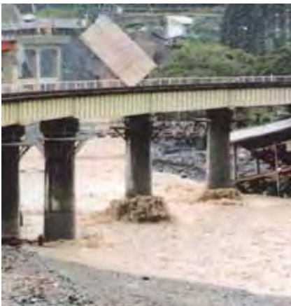
図 6.5.1 出水時における橋脚周辺の水面状況（姫川）
