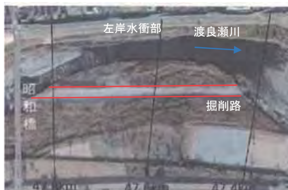
図 5.4.2 掘削路の施工状況
