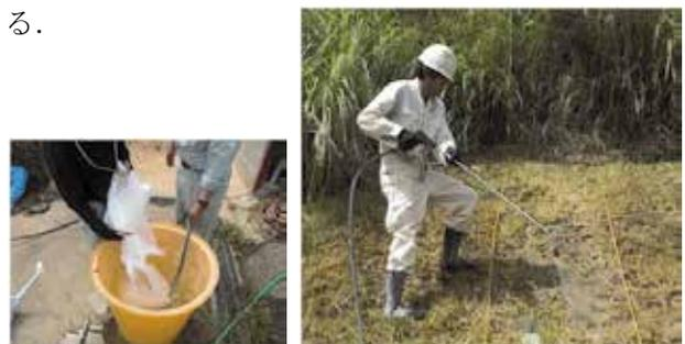
写真 4・2 重曹水溶液の作成及び散布の状況
