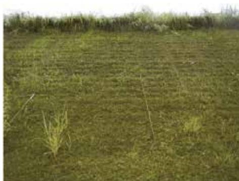
写真 8-1 イワダレソウを植栽した堤防法面（施工後 1 年 6 箇月）
