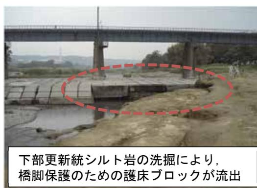
図1・1 泥岩・沖積粘性土層露出河道の例
