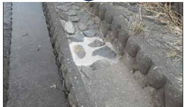
写真 5・1 堤防護岸の補修事例
