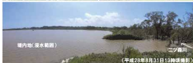
図-1 ニッ森川の被災箇所及び被災状況 (平成28年8月31日13時頃撮影)
