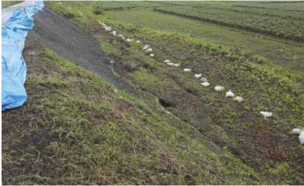
子吉川右岸10.8kmののりすべりの状況(応急復旧後で、欠損部には碎石充填済み)
